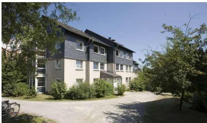
Abbildung 13: Wohnheim Laerholzstraße 7-13b [13]
