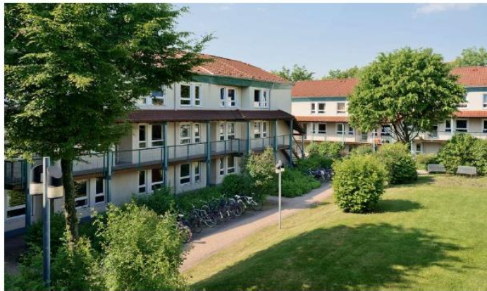
Abbildung 8: Wohnheim „Am Grimberg“ Stiepeler Straße [8]
